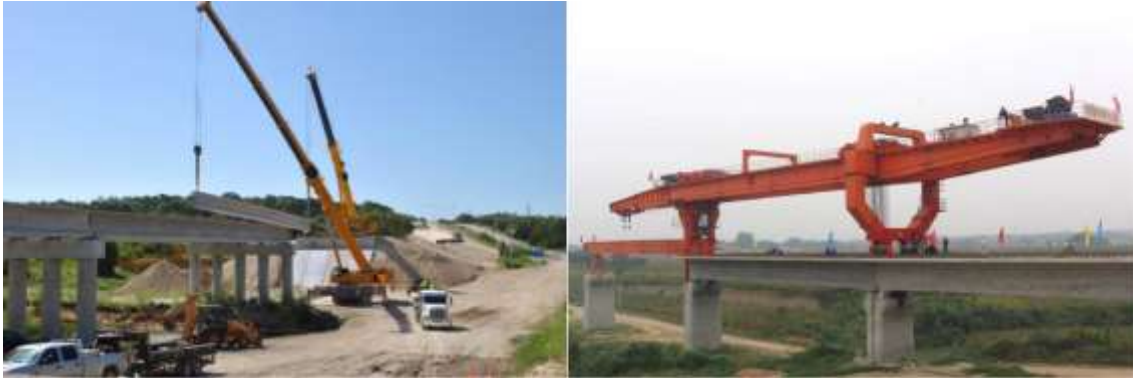
Figura 3: Vendosja e trarëve në vepër për lartësi pile <20.00m dhe > 20m
